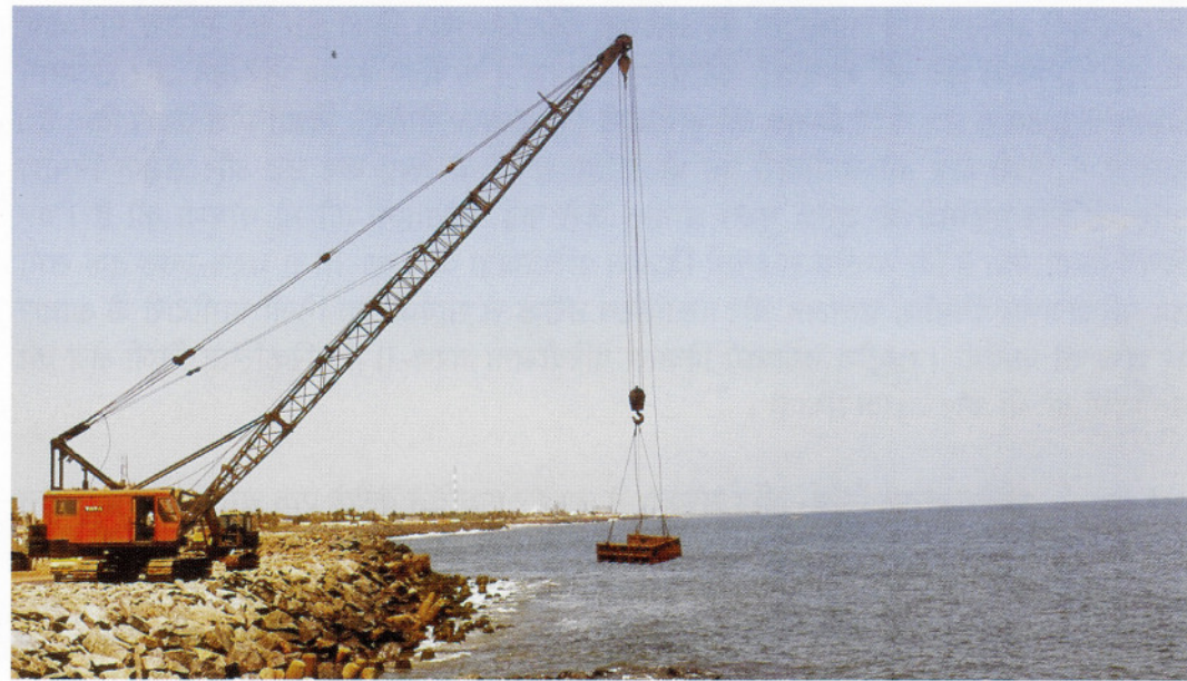
ग्रोन चन्नै पोर्ट कनेक्टिविटी प्रोजेक्ट का निर्माण कार्य द्वारा समुद्री संरक्षण कार्य
