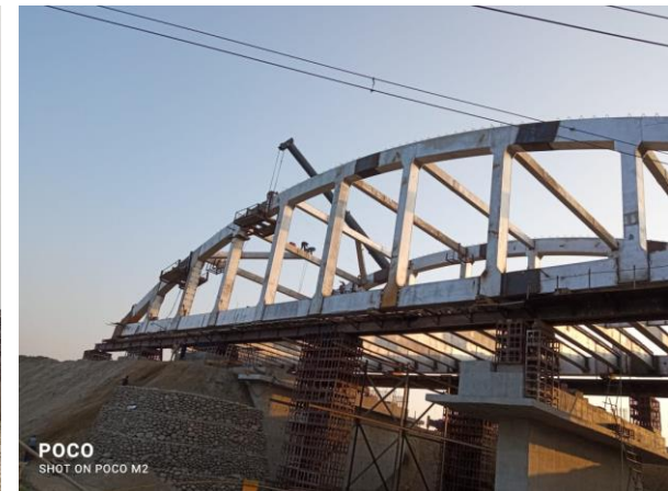
(d) Photo: Completing the assembly of Bow String Girder
